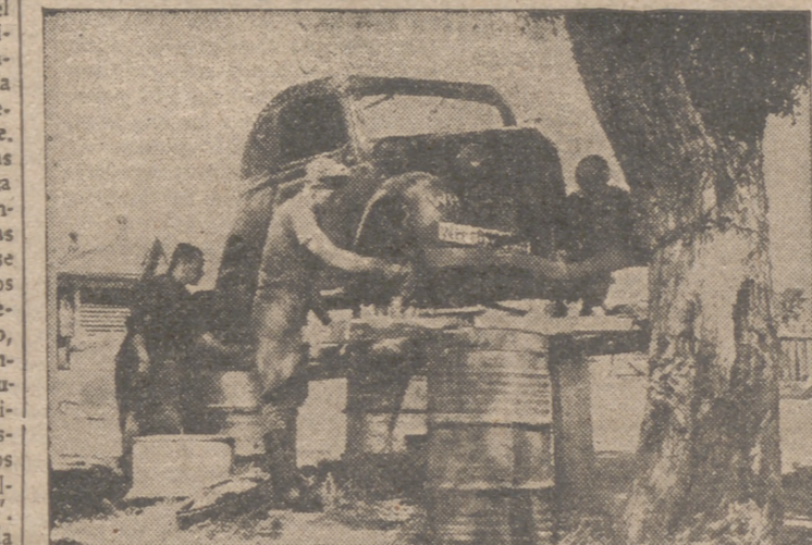
TALLER DE REPARACIONES EN EL FREENTE.—Los soldados alemanos son siempre muy prácticos, y cuando se carece de un confortable taller con elevador de coches, ellos se lo construyen con cuatro bidones y unos maderos
