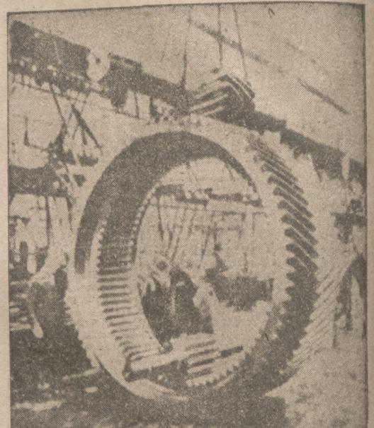
La foto muestra un gigantesco engranaje para máquina laminadora con corona forjada y piñones de acero. El peso total es de 26 toneladas
