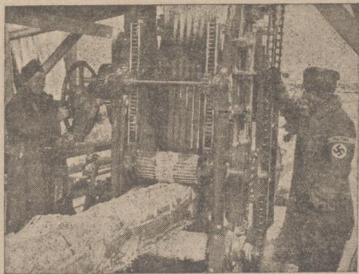
En pleno campo, esta máquina de aserrar prepara los troncos de madera que van a ser empleados para la construcción de carreteras
