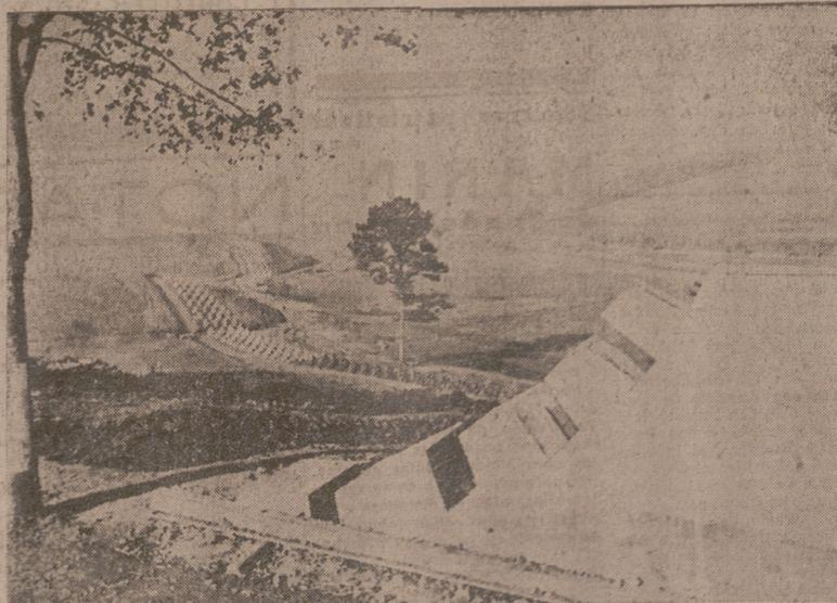
Los obstáculos en forma de mojoneros y fuertes murallas de cemento armado impiden el paso de los tanques, formando una línea continua que pasa sobre montañas y valles
