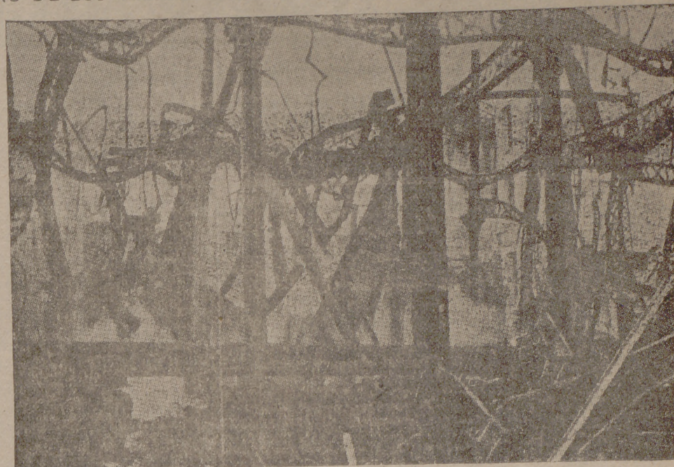
Vista interior de las "Nouvelles Galeries" después del siniestro
