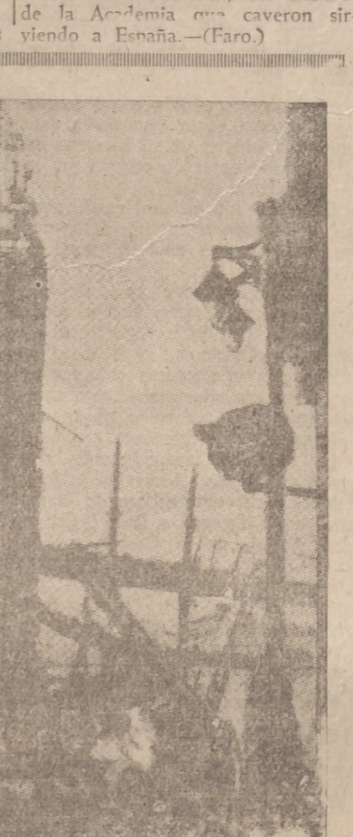
Estado en que ha quedado uno de los edificios incendiados en Marsella
