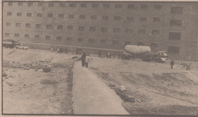
Así estaba el Barrio de Las Fuentes mientras se cambiaban totalmente las instalaciones de agua.
