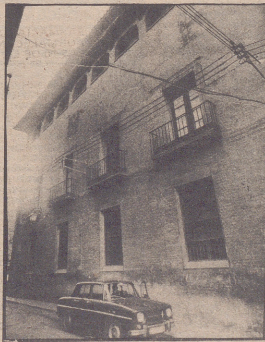
Medianería con acceso por Espoz y Mina
