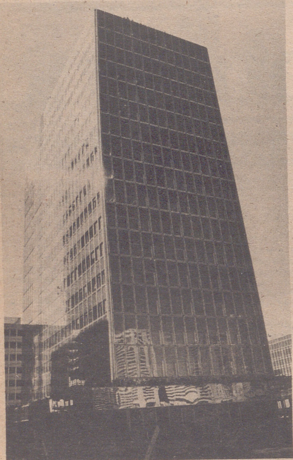
MADRID.— Ha quedado inaugurado el primer edificio madrileño que utilizará la energía solar para la refrigeración interior. Este edificio es un rascacielos situado en el moderno complejo AZCA, consta de 84 metros de altura, con 878 metros cuadrados, cinco sótanos y dieciséis plantas de oficinas. (FOTO EFE)
