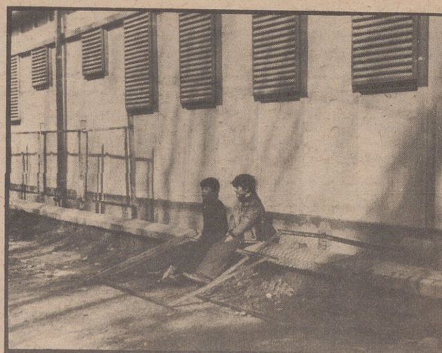
Las vallas metálicas rotas e inservibles que no protegen (Foto Luna)
