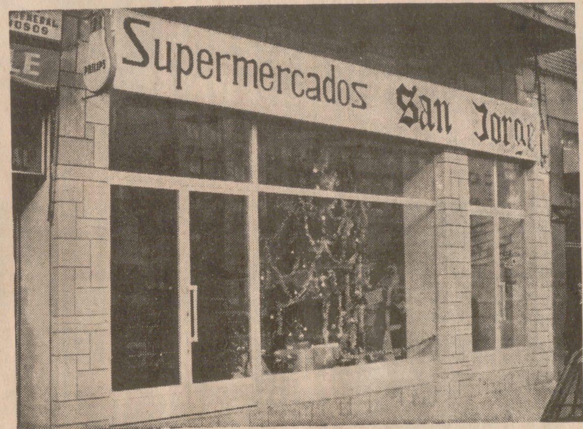
Fachada principal del Supermercado San Jorge, en Duquesa Villahermosa, núm. 4
