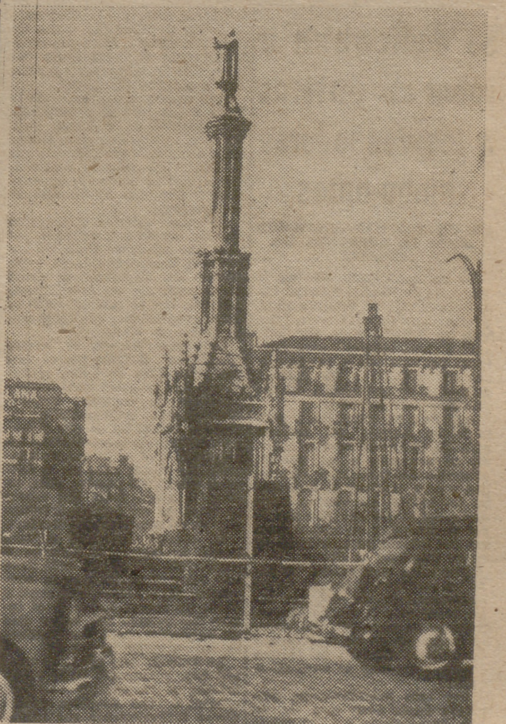
Se han terminado las obras realizadas en la plaza de Colón para tapan el socavón producido por el reciente hundimiento. Sólo quedan ultimar algunos trabajos de jardinería para dejar limpio y reluciente el citado importante nudo de comunicaciones. (Foto Torremocha)
