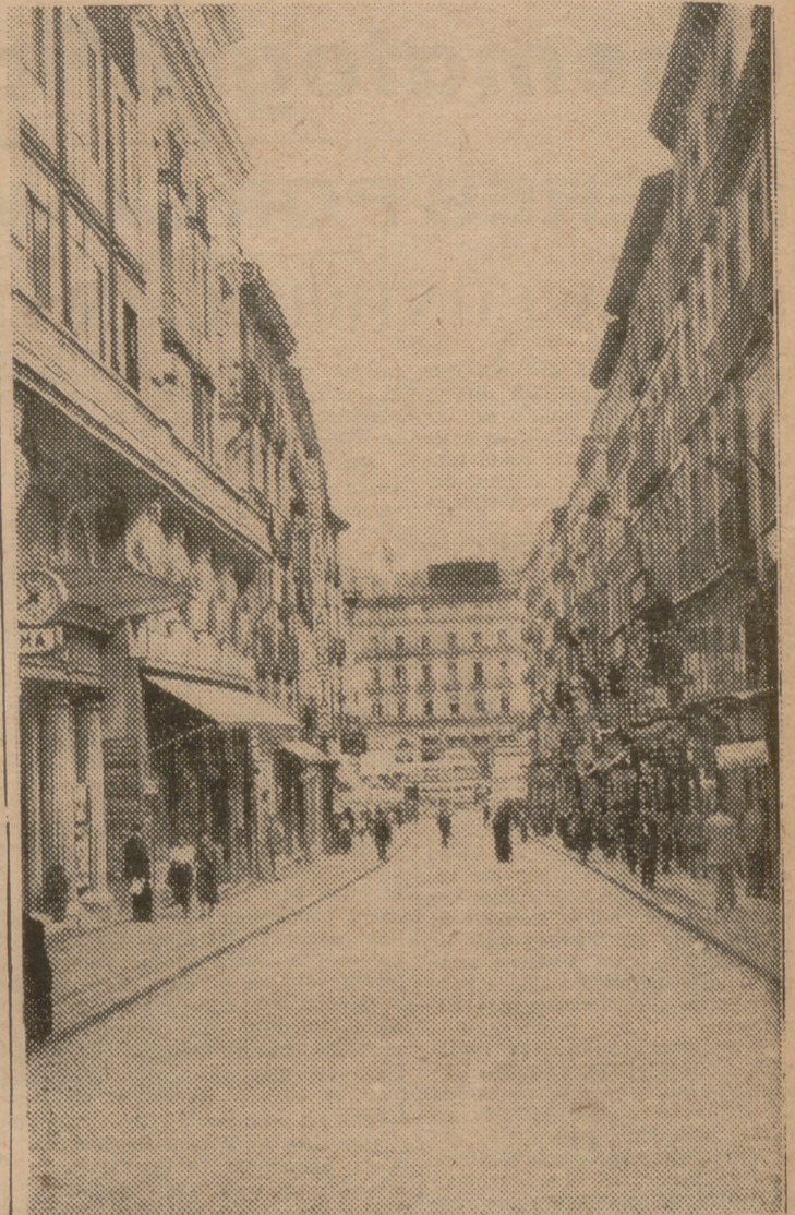
La calle de Carretas ofrecía a las once menos veinte de la mañana de ayer este aspecto tan distinto al de hace unos días y al de hace un año. Las obras de esta calle tan popular se han acabado antes del tiempo señalado, ejemplo que debe cundir siempre en la Villa del Oso y el Madroño. (Foto Cifra.)
