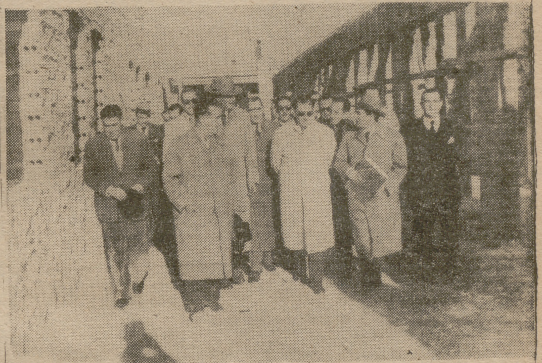
El gobernador civil, acompañado del subje provincial del Movimiento, del delegado provincial de Sindicatos y de otras autoridades, visitando las obras.
