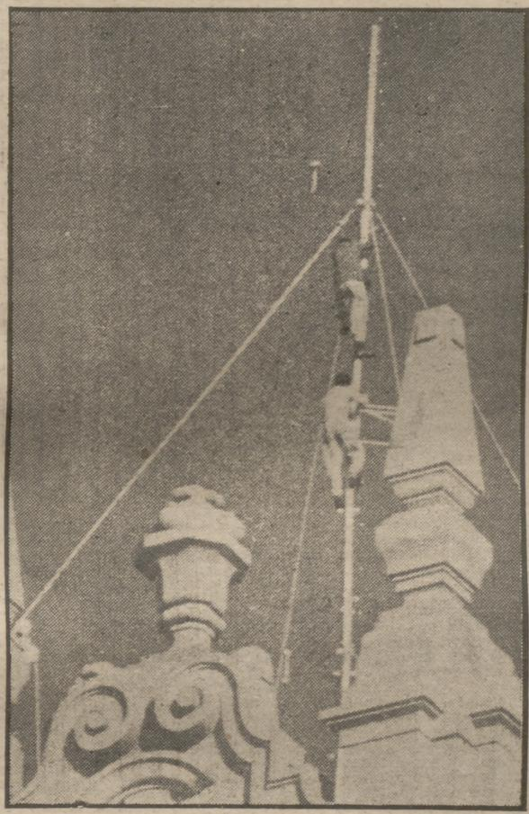
Sobre los 96 metros de altura de la torre del edificio de la Telefónica ha sido levantada una antena de 16 metros, en la cual trabajan los obreros que muestra la fotografía. Esta antena se utilizará para el Servicio Urbano Móvil, que permitirá las comunicaciones telefónicas con los automóviles. Este servicio comenzará próximamente, y si ustedes saben el número de teléfono de su taxi preferido podrán llamarlo desde su casa cuando no esté comunicando. (Foto Cifra.)
