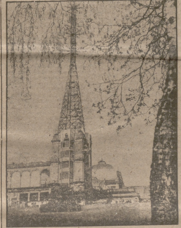
Un ángulo del Alexander Palace, donde están instalados los servicios de televisión de la B. B. C., sobre el que se alza una de las torres que sustentan las antenas de esta emisora.
