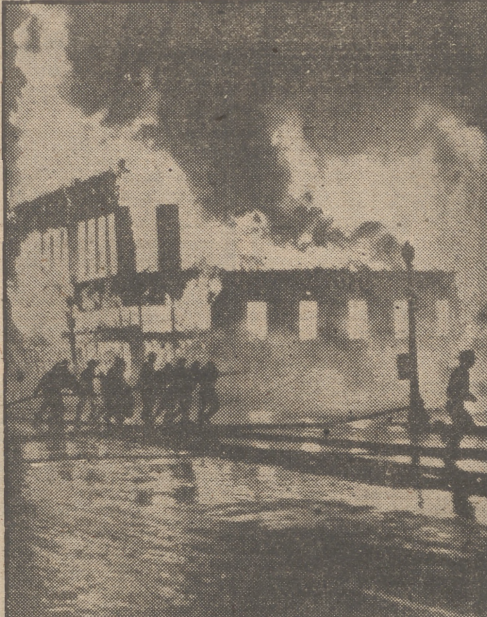
Estos bomberos americanos se batieron en retirada en la lucha por sofocar un incendio cuando una de las paredes del edificio en llamas amenaza con desmoronarse. La escena, en la población de Dugando, Estado de Colorado, el día 16 de febrero. Los daños causados por la conflagración se calculan en un millón de dólares. (Foto A. P.)
