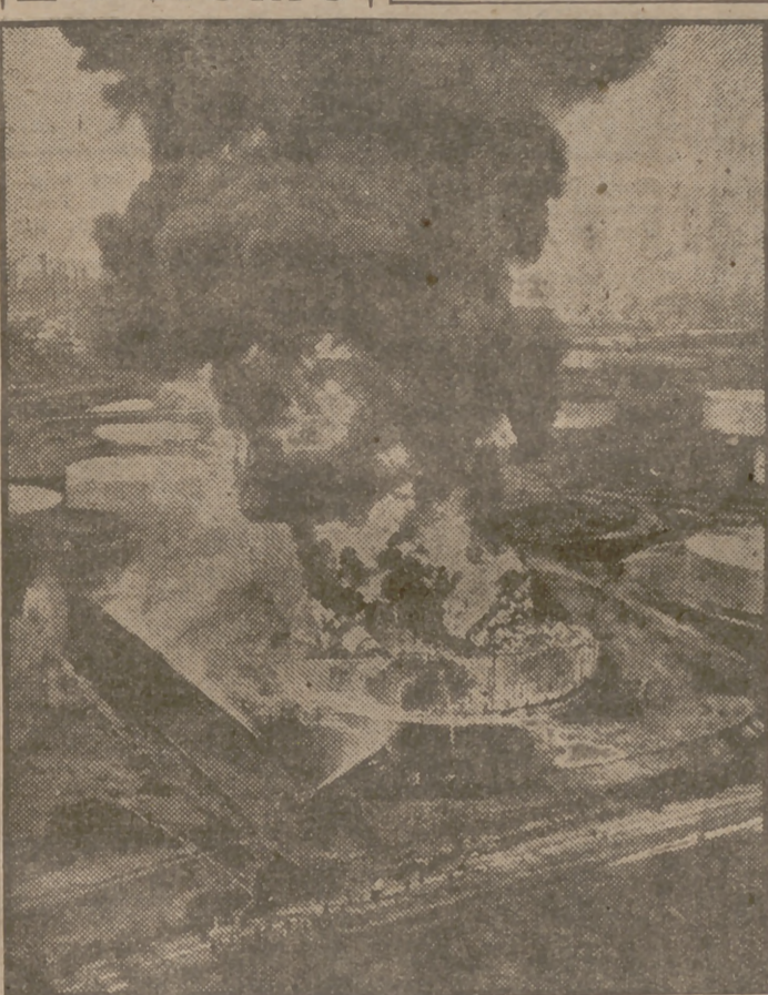
Un tanque de gasolina fué pasto de las llamas en la refinería de la Standard Oil, en El Segundo (California). Después de una explosión terrible el tanque voló por los aires, ocasionando al caer la muerte de un obrero. He aquí, convertido en negra nube de humo, el preciado líquido cuya carestía tantas dificultades crea al mundo entero. (Foto A. P.)
