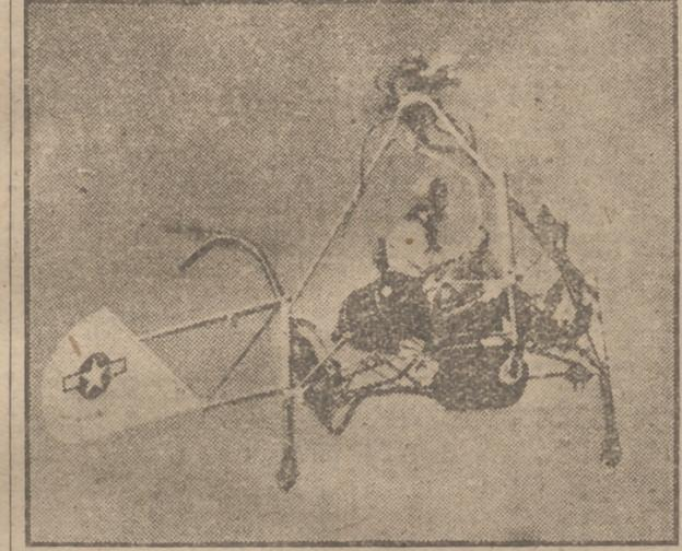
El helicóptero-motocicleta, de fabricación americana, con motor de reacción, realiza sus pruebas en la fábrica constructora de St. Louis, Estado de Missouri. El aparato, que pesa solamente 310 libras, elevó 300 libras más, volando a una velocidad de 50 millas por hora.
