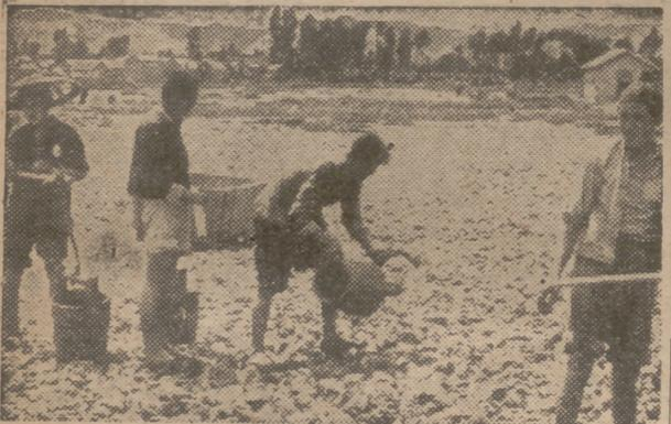
Obreros chinos cubriendo de mezcla la capa de piedra que servirá de firme a un nuevo aeródromo en Extremo Oriente. (Foto A.)
