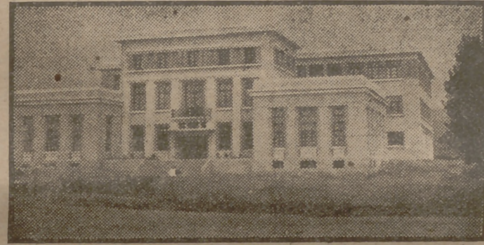
Entre otros edificios públicos, S. E. el Jefe del Estado inauguró recientemente en La Coruña esta magnífica construcción, donde ha sido instalado el nuevo Instituto de Segunda Enseñanza. (Foto Cifra.)
