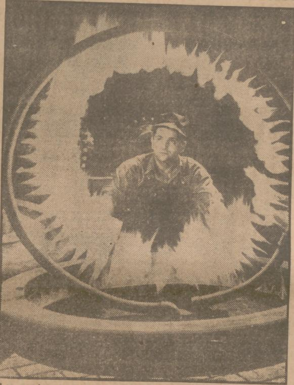
Las ruedas de las locomotoras eléctricas son calentadas por medio de este aro con mecheros de gas, en la operación preliminar a la colocación de las llantas de acero. He aquí el curioso aspecto de uno de estos aros en los talleres de la Compañía General Eléctrica de Erié, en Pensylvania. (F. A. P.)
