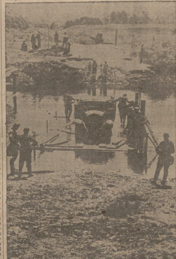
He aquí la fotografía de un camión militar alemán flanqueado un río por medio de lanchas con plataformas portátiles. Los puentes en Rusia eran demasiado débiles para soportar el peso de las fuerzas acorazadas, y en su mayoría estaban destruidos.
