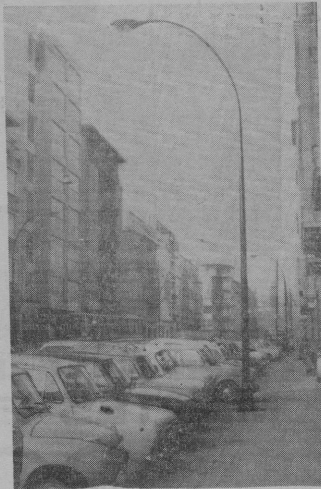
CALLE GENERAL RICARDO ORTEGA. HOY ES PRIVILEGIADA, YA QUE TRÁS EL ARREGLO DE LA CALZADA Y DE LAS ACERAS, SE INSTALO EL ALUMBRADO PUBLICO. A BASE DE ESTAS GIGANTESCAS Y MODERNAS TORRES. HACE QUINCE DIAS QUE ALUMBRAN... PERO TODAVIA NO HAN SIDO QUITADOS LOS ESCOMBROS A CONSECUENCIA DE LAS OBRAS. (Foto Ribas)
