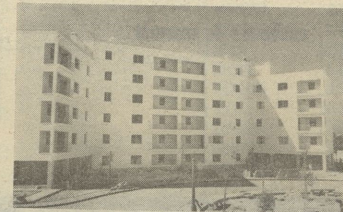
VISTA PARCIAL DEL GRUPO DE VIVIENDAS SINDICALES, "VIRGEN DE LLUCH", 2ª. FASE.
