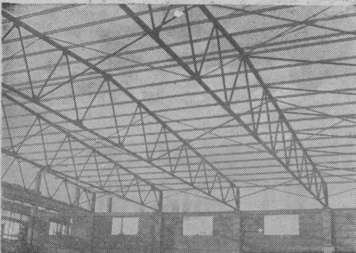
CUBIERTA METÁLICA PARA «C.A.M.P.S.A.» MAHÓN.
