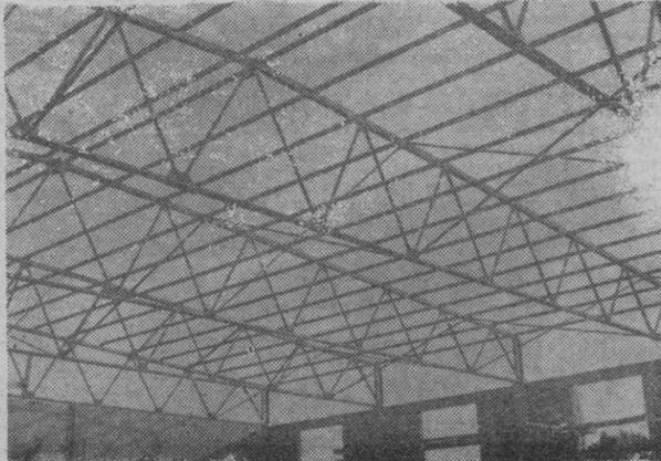
CUBIERTA PARA FABRICA DE BEBIDAS CARBONICAS «BEBA-SALUD». ARMADURAS DE 30 METROS DE LUZ. POLIGONO INDUSTRIAL DE «SON CASTELLO».
