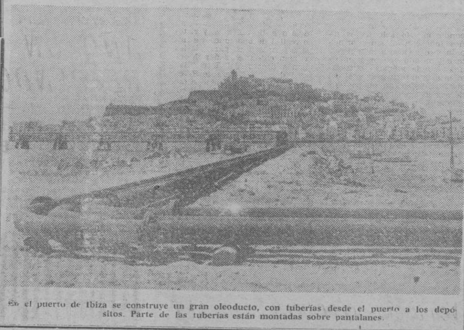
En el puerto de Ibiza se construye un gran oleoducto, con tuberías desde el puerto a los depósitos. Parte de las tuberías están montadas sobre pantalanos.
