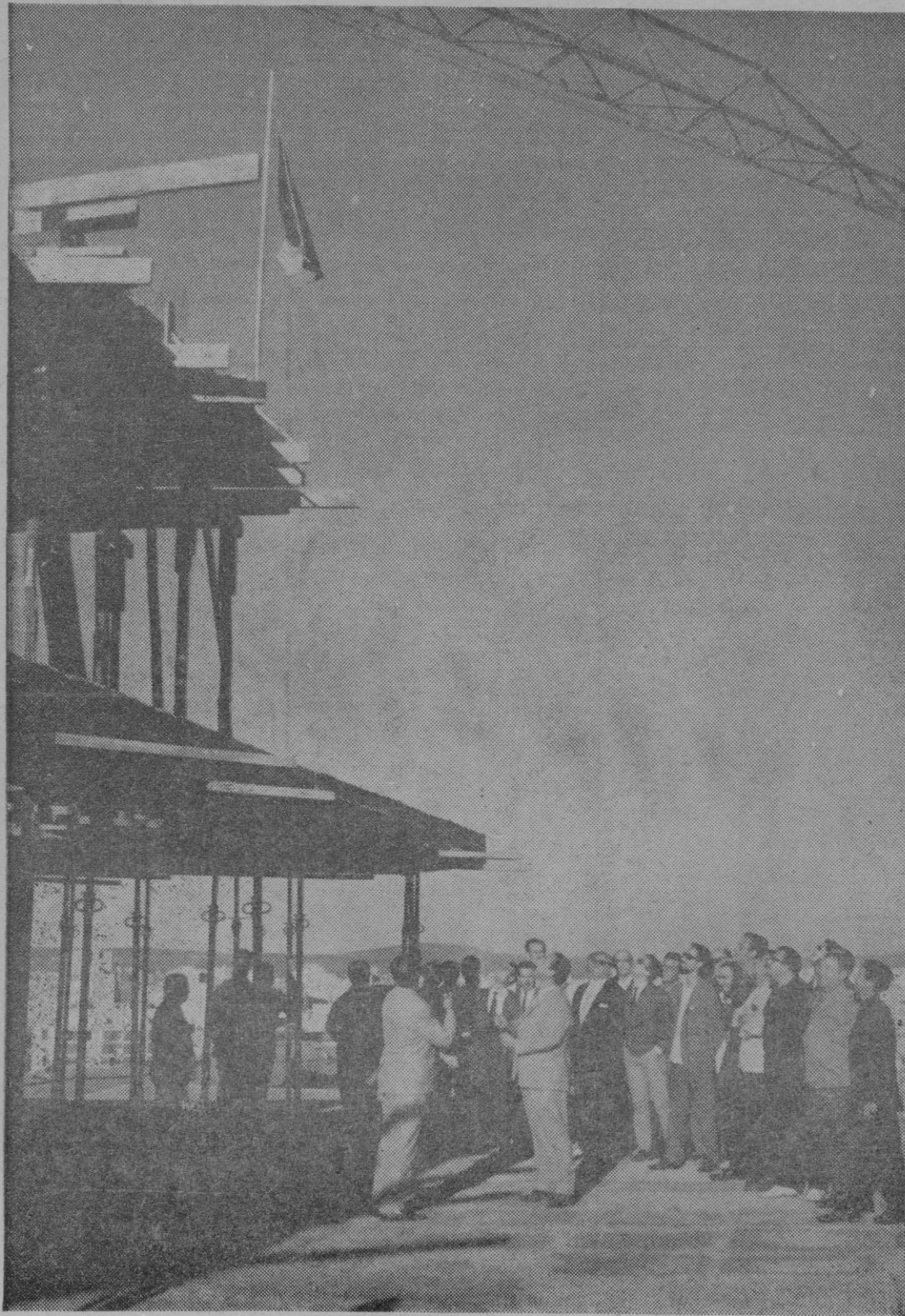
MOMENTO DE IZARSE LA BANDERA, CON LO CUAL SE DABA POR TERMINADA LA ESTRUCTURA DEL EDIFICIO. — (Fotos Castell.)
