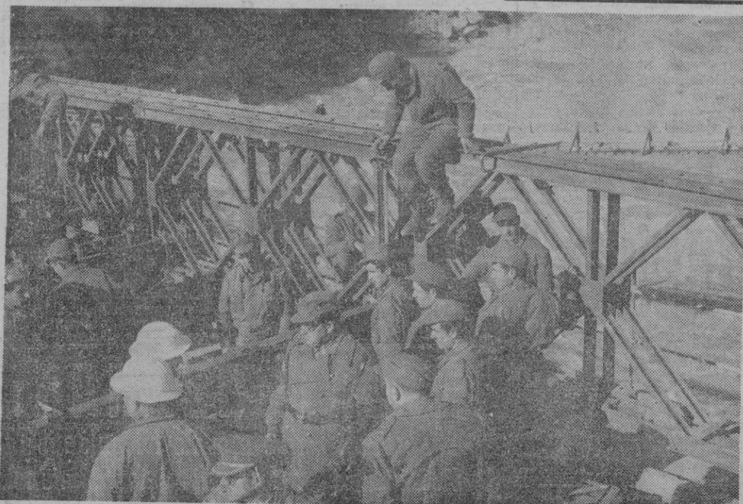
Aldeadevilla (Salamanca). — Un puente desmontable del Ejército ha sido instalado en esta localidad por los pontoneros. Este puente, provisional, viene a sustituir al que las aguas se llevaron recientemente, y facilitará la continuación de los trabajos de construcción de una gran presa de Iberduero en esta zona. Mide más de cuarenta metros y ha sido instalado en menos de veinticuatro horas. — (Foto Cifra).
