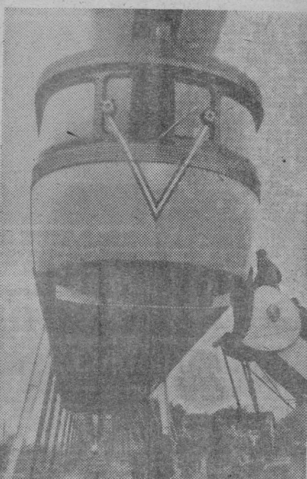
La casa Renault ha presentado en Chateaufort-sur-Loire un metro aéreo monocarril que funciona suspendido de una vía de un kilómetro y medio de longitud. El sistema es rápido, silencioso y cómodo. El tren puede marchar a una velocidad de 100 Km. por hora.
