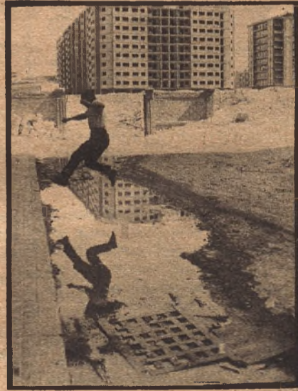
La pestilente charca, que inundan de nauseabundos olores toda la barriada.
