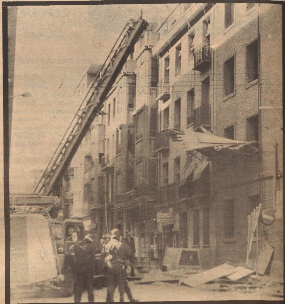
Esta es la casa número 32 del Paseo de las Damas, esquina a Doctor Casas, donde a media mañana se ha producido el dramático accidente laboral. Por el hueco del cañizo del primer piso cayeron los tres trabajadores a la calle.
