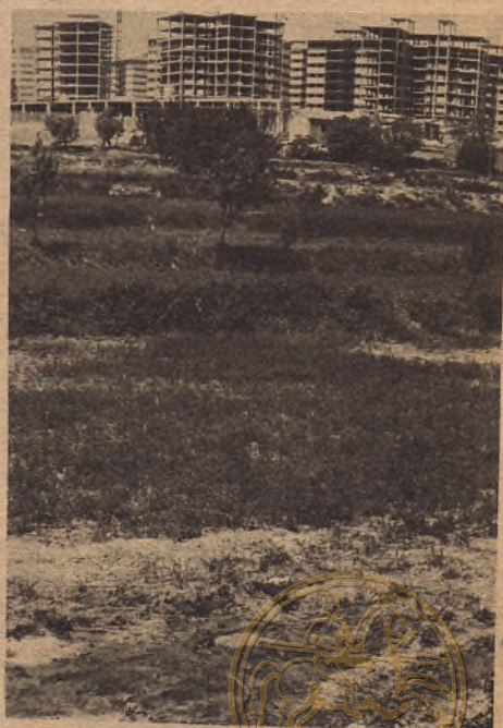
En primer plano, aguas residuales a la luz del día. Y todavía no están habitadas las torres que se construyen al fondo
