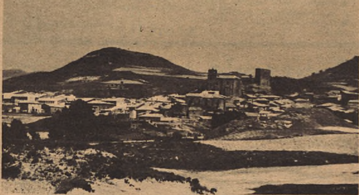
Bella panorámica de la villa de Luesia. En la parte más elevada de la población, se pueden admirar el templo de arquitectura romana del Salvador y el de San Esteban, de estilo románico mandado construir por Alfonso I el Batallador
