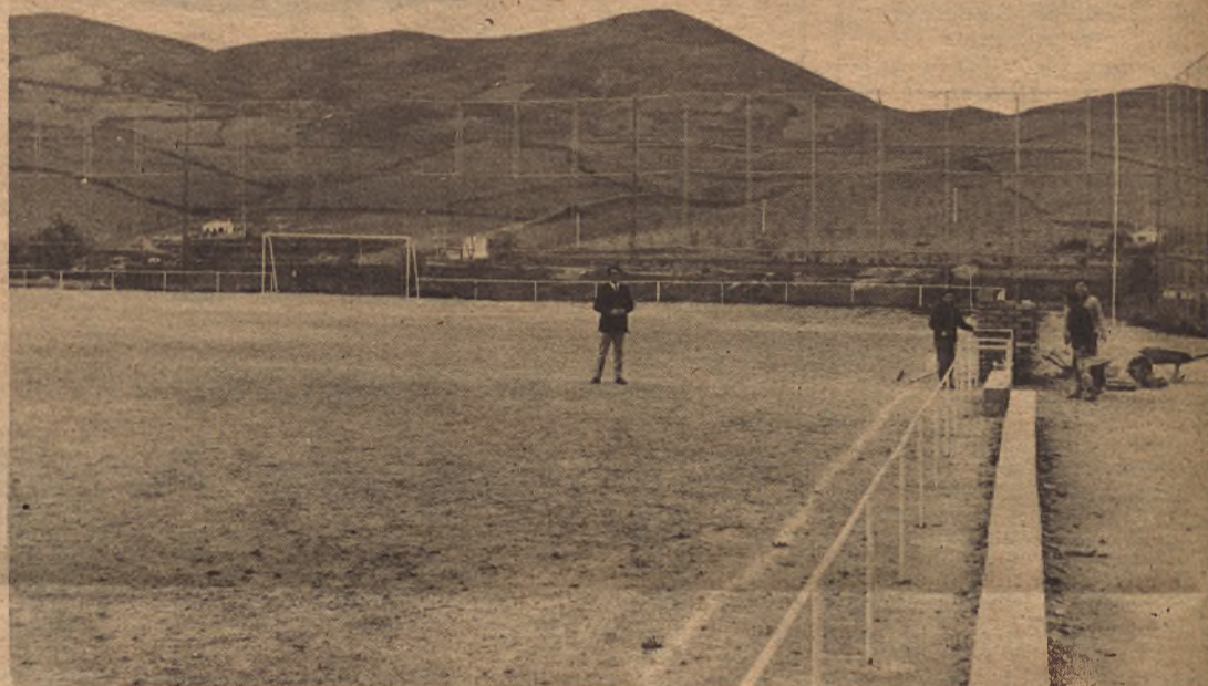
Campo de fútbol de San Blas. Se están construyendo banquillos cubiertos para los reservas, entrenador y masajista.
