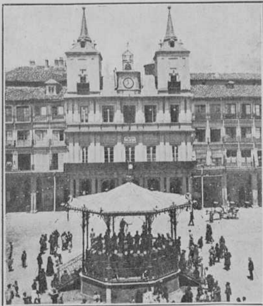
Fachada del Palacio municipal de Segovia.
