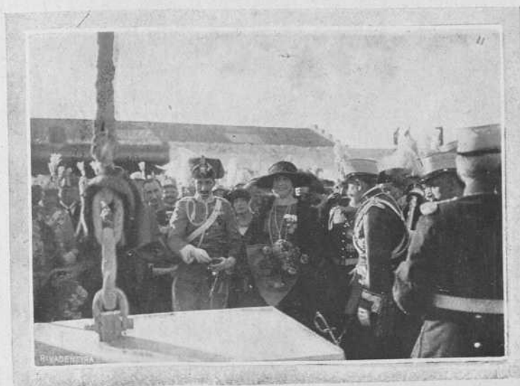
Los Soberanos en el acto de la colocación de la primera piedra de la nueva Academia de Caballería.
