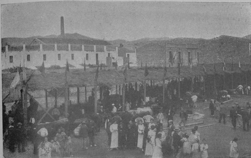
Vista general de las instalaciones.
