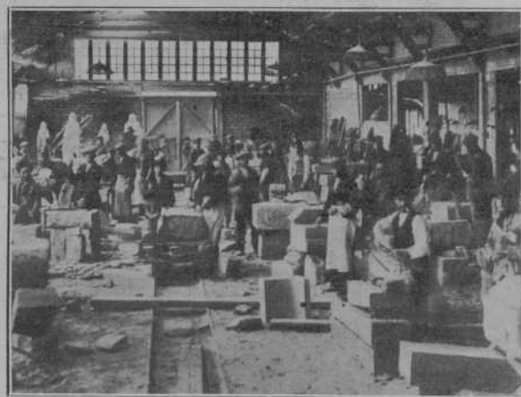
Detalle parcial de la nave de martillos neumáticos
