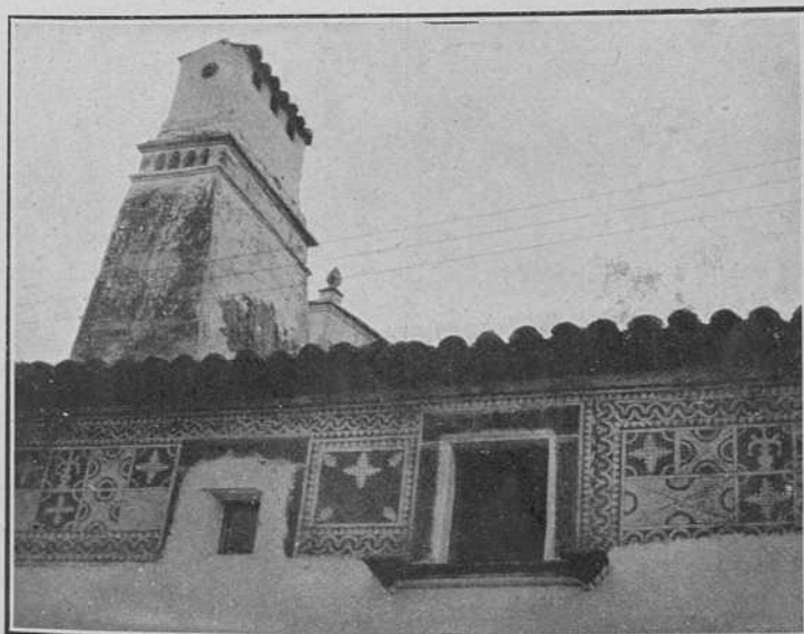
Esgrafiado en Arroyo del Puerco
