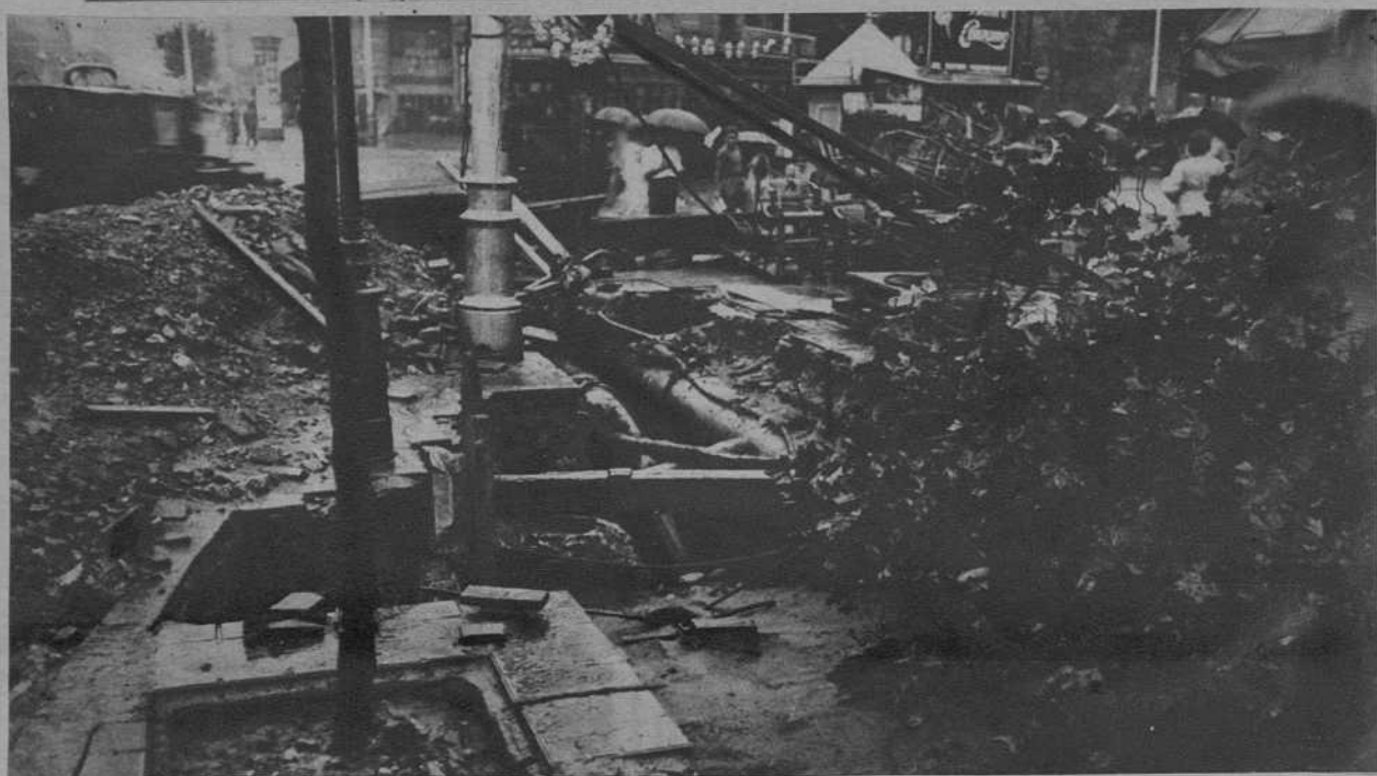
El hundimiento del pavimento junto a la Brecha de San Pablo. — (Fot. Pérez de Rozas)
