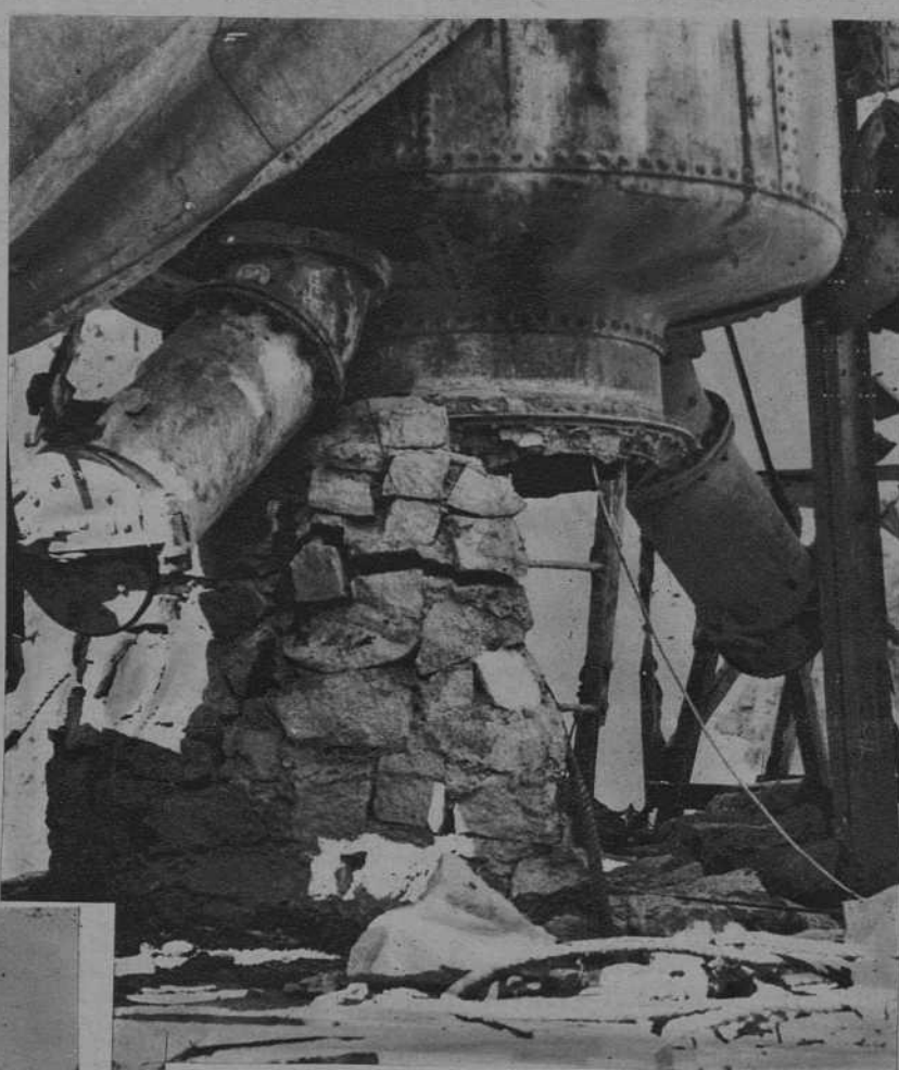
Estado en que quedó la campana de aire comprimido.
