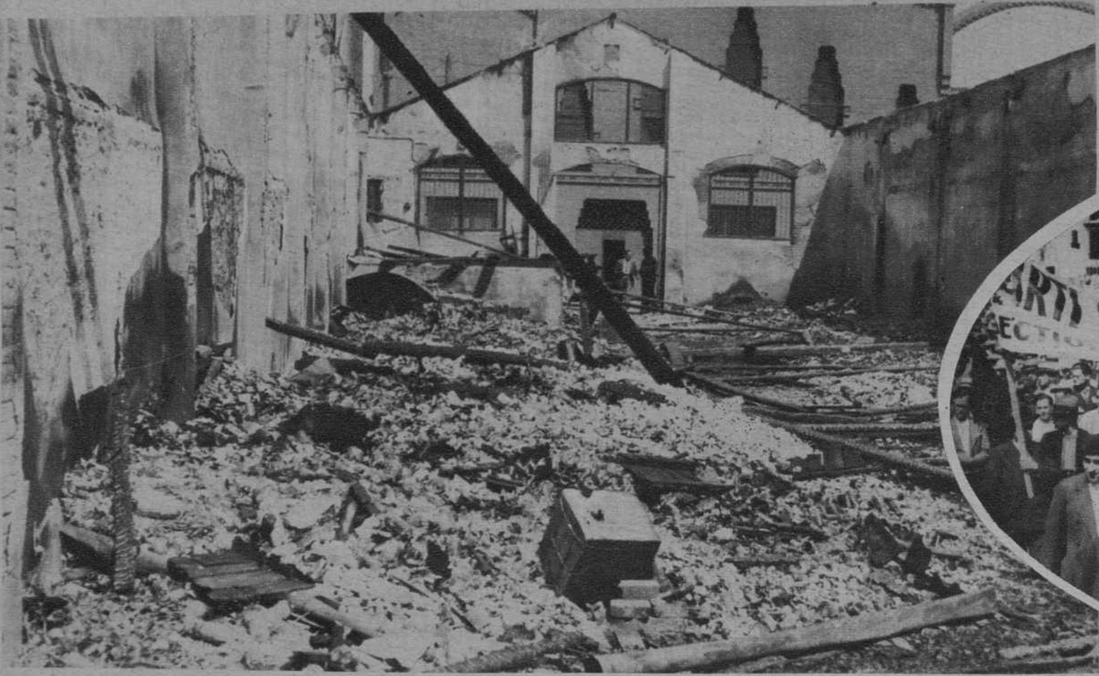
Estado en que quedó, a consecuencia del acto de sabotaje cometido, la fábrica de vidrio de la calle del Taquígrafo Garriga. — (Ft. Badosa)
