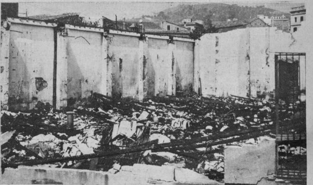
La fábrica y almacén de camisería de la calle de la Industria, destruida la noche del jueves por un incendio. El almacén.—(Fot. P. de Rozas)
