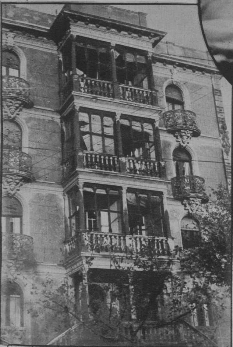
Casas hubo donde no quedó cristal sano ni persiana sin destrozos.—(Fots. Barrera)
