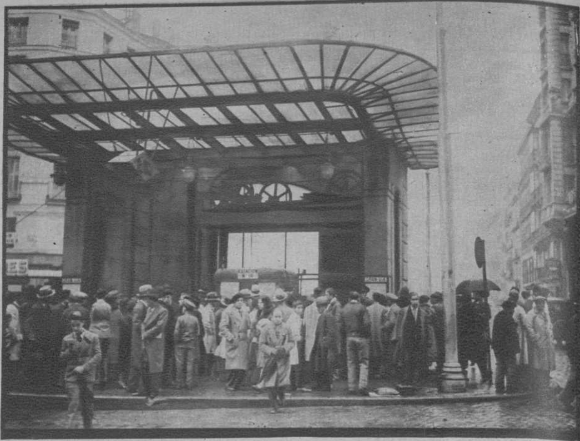
Madrid.—Del accidente en la estación del Metro, de la Gran Vía, en el que resultaron dieciocho personas heridas. La estación de la Gran Vía
