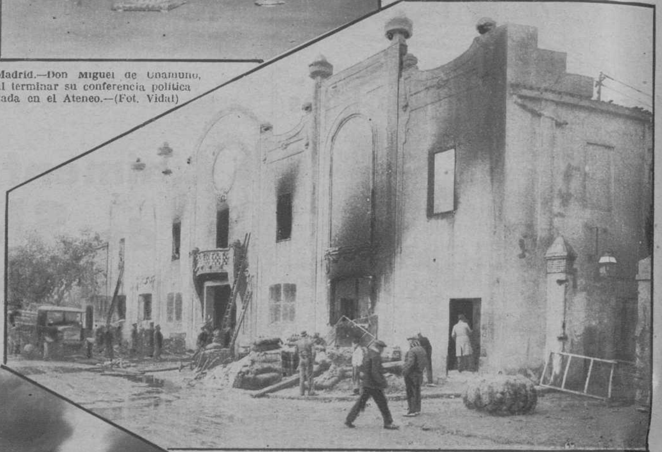
Badalona.—Fachada de la fábrica Ribó, después del incendio que la redujo a escombros.—(Fot. Merletti)
