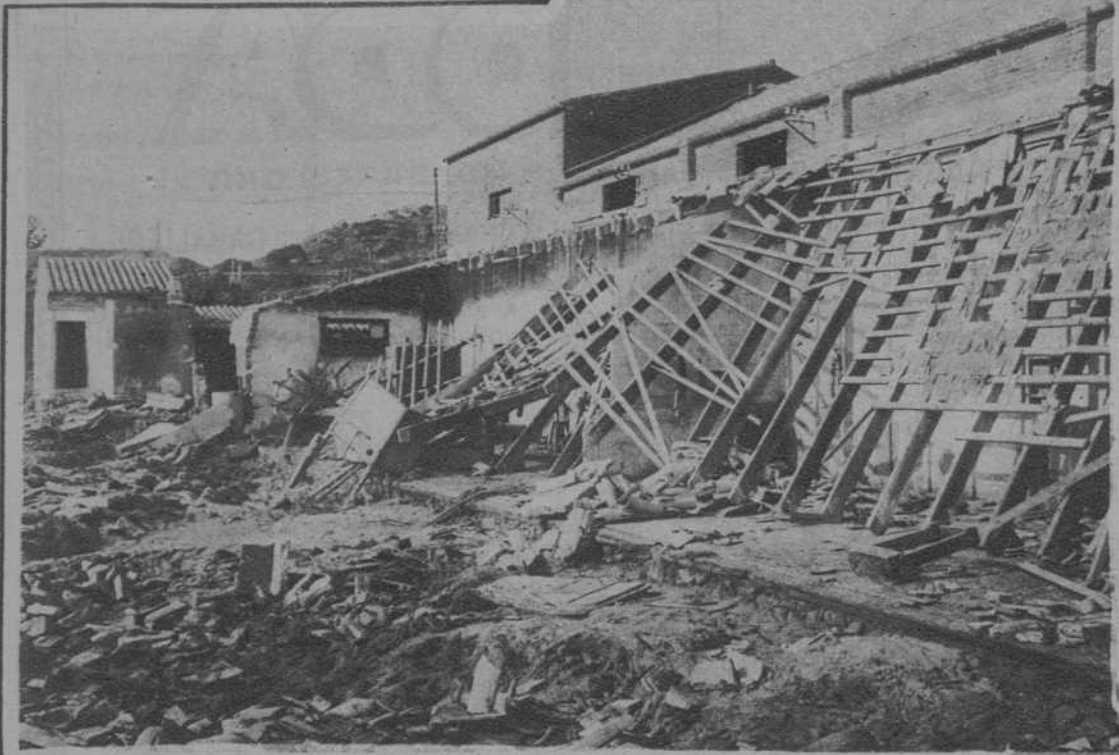
Aspecto exterior de la fábrica de bastones del señor Esteve, destruida por la furia de las aguas. — (Fots. Merletti)
