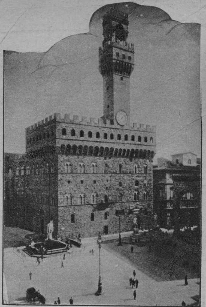
La torre sube a las nubes, como un canto a la municipalidad y a la República
